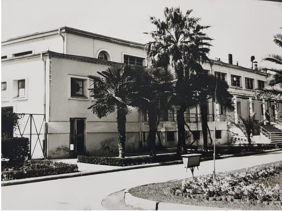
Fabrika Sosyal Tesisi (Tiyatro ve Sinema Salonu)
